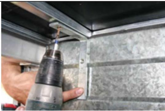
Fixieren Sie einen Winkel an jede Stahlstrebe des Zeltrahmens im inneren des Anhängers.
