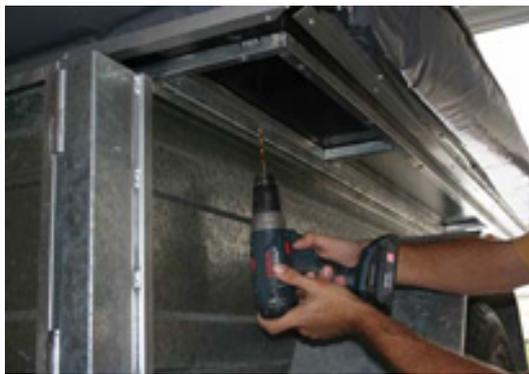
Sobald Sie mit der Position des Zeltes zufrieden sind, können Sie das Zelt mit dem Scharnier von unten verbinden. Hierzu bohren Sie Löcher der Größe Ihrer Niete von unten durch das Scharnier und den Rahmen. Bitte bohren Sie nur durch die erste Wand des Rahmengestänges und nicht vollständig durch den Zeltboden. Bei alternativer Verwendung von Edelstahl Bohrschrauben (heavy duty) sind diese Bohrungen nicht notwendig.
